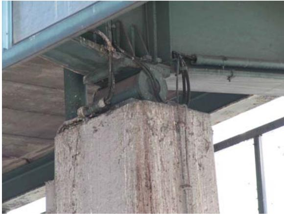
Das Dach ruht bis auf die durch die Gebäude vormals ausgesteiften Endpfeiler auf Rollenlagern, so dass Längenänderungen durch Temperaturendehnungen Richtung Nord- und Südflügel stattfinden können. Eine Aussteifung war wegen der Gebäude am Ende der Konstruktion, die die Schubkräfte aufgenommen haben, nicht notwendig und ist auch nicht vorhanden.
