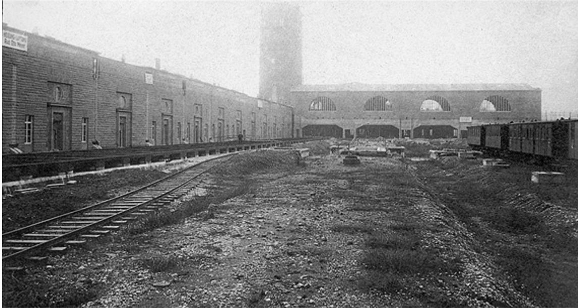
Die Stützen des Daches sind auf diesem Bauzustandsbild nicht zu erkennen. Vermutlich wurde das Dach in der jetzigen Form in den 60-er Jahren auf die Stützen gestellt. Nord- und Südflügel waren da vorhanden, und auch der seitliche Windschutz von Norden durch den „Güterschuppen Versand“.
