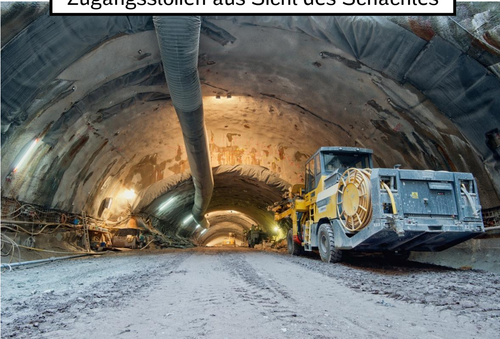
Zugangsstollen aus Sicht des Schachtes
