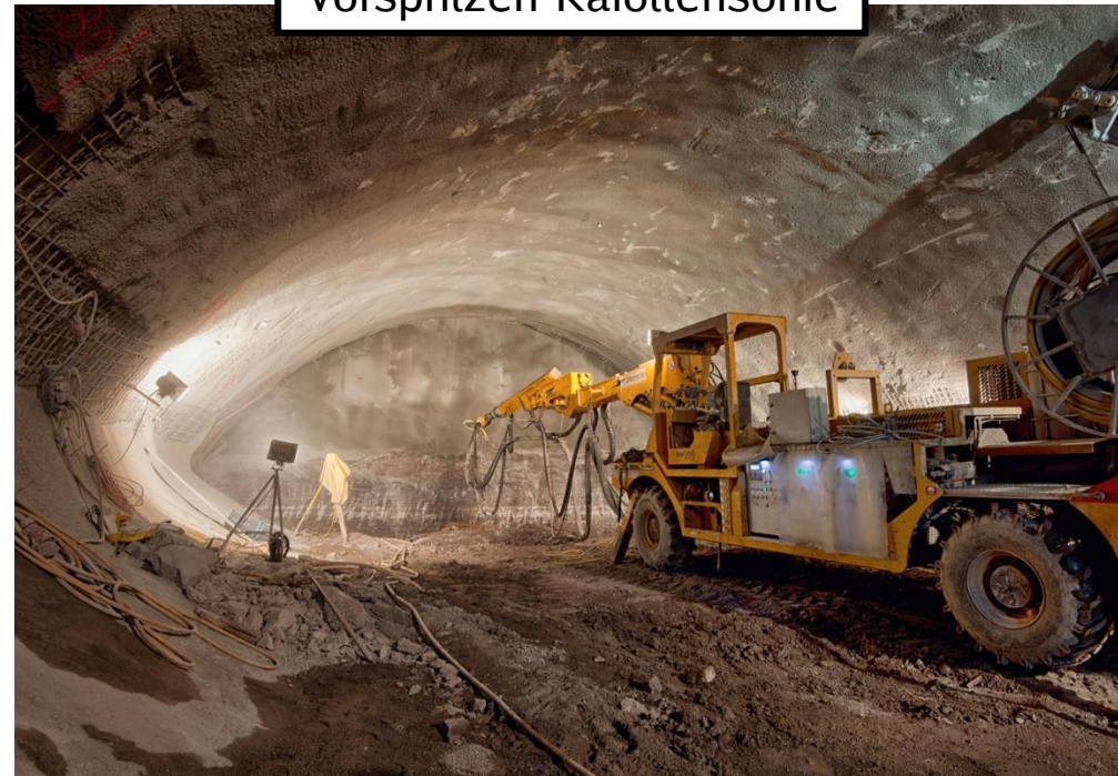
Vorspritzen Kalottensohle
