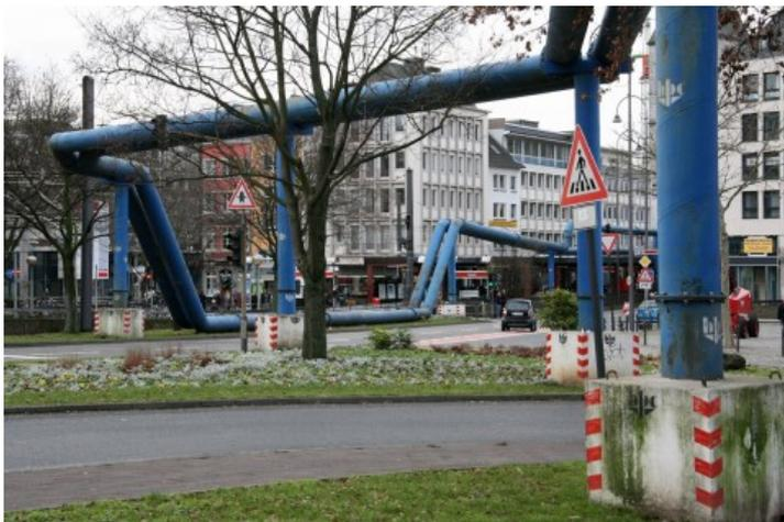
*Visualisierung des für die nächsten Jahrzehnte drohenden Bahnhofsanblicks in Stuttgart durch ein 17 km langes Grundwasser-Management-Rohrleitungs-System. Was auf der Bildmontage noch fehlt sind die vermutlich bretterzaunverschalteten Baueinrichtungsflächen BE 7 - 9 entlang der gesamten Bahnhofsfrent, siehe Baupläne weiter oben.*
